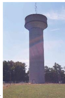
Réservoir de Combrand :
