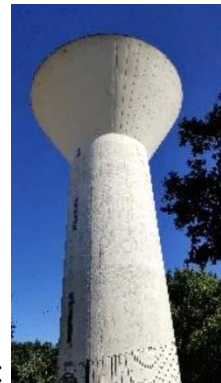
Réservoir de St Aubin du Plain :
