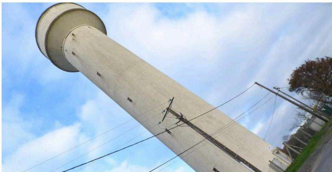
Vieillissant, l'actuel château d'eau de Sanzay est situé à un point névralgique du réseau d'eau potable du Nord-Deux-Sèvres. © (Photo NR, Dominique Guinefoleau)
